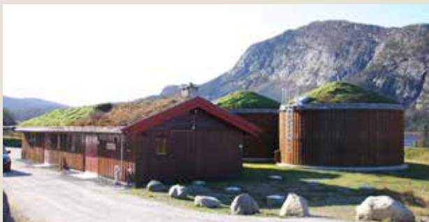
Haglebu renseanlegg, levert av BIOVAC.
